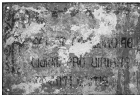
Un'area della decorazione e un particolare interessati dalle infiltrazioni con le conseguenti efflorescenze saline e da cadute di colore.
